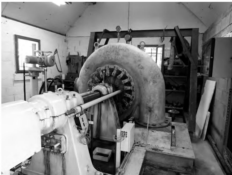
Turbine Monvalvi, Pavie, de la centrale de Sewen ; conduite forcée Rieter, Winterthür, de l'ancienne turbine de la filature d'Oberbruck.
