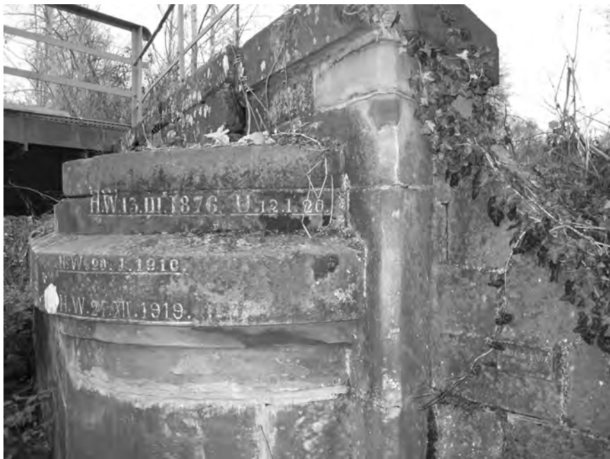
Photo 1 : repères de crue du pont de chemin de fer au-dessus de la Lauch dans la forêt du Neuland au sud de Colmar. Un exemple remarquable et unique en Alsace, où figurent les inondations de mars 1876, janvier 1910, décembre 1919, janvier 1920 et, dans le bas de la photo à droite, une petite plaque rouillée indiquant la crue d'avril 1983, événement de référence, pourtant bien en dessous des crues précédentes.
