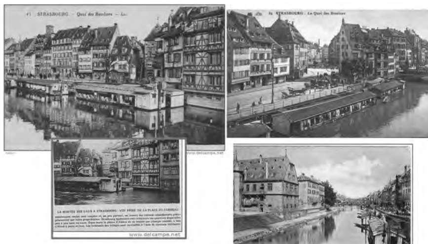
Fig.3 : détermination d'un repère crue à partir d'une photographie ancienne issue d'un article de presse, et cartes postales anciennes, au pont du Corbeau à Strasbourg
