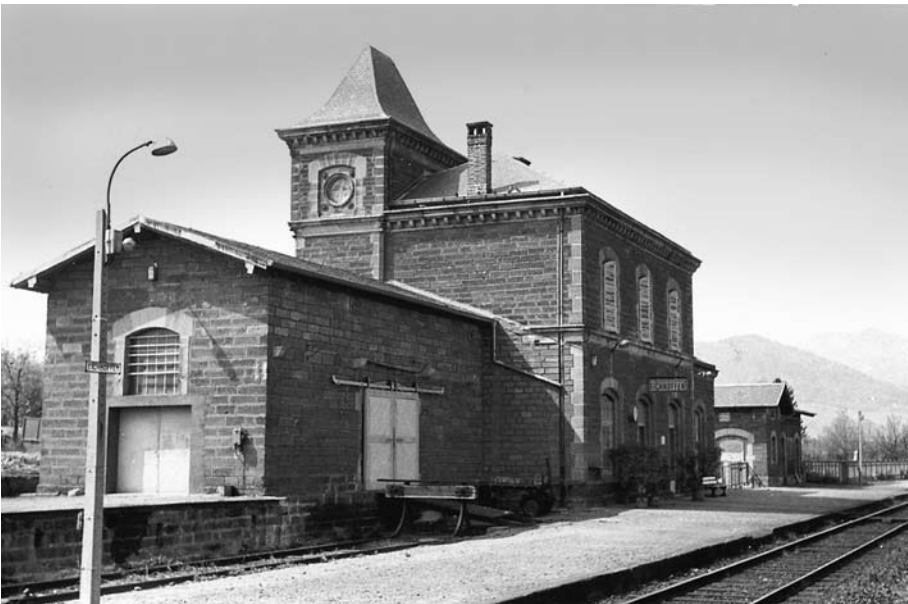
La gare-donjon de Eichhoffen sur la ligne 17-05 Sélestat-Molsheim, représentative de ce standard de construction parée en pierres de taille. La halle à marchandises est accolée, les toilettes, buanderie et remise sont rassemblées dans le bâtiment annexe (Photo Claude Gerrer en 1976).
