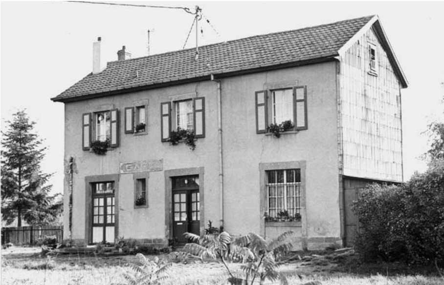
La gare de Guewenheim, typique des chemins de fer de l'Est.. Le corps de bâtiment de type "A" (partie gauche) est complété d'une travée pour former un bâtiment de type "B". Photo Claude Gerrer en 1976.
