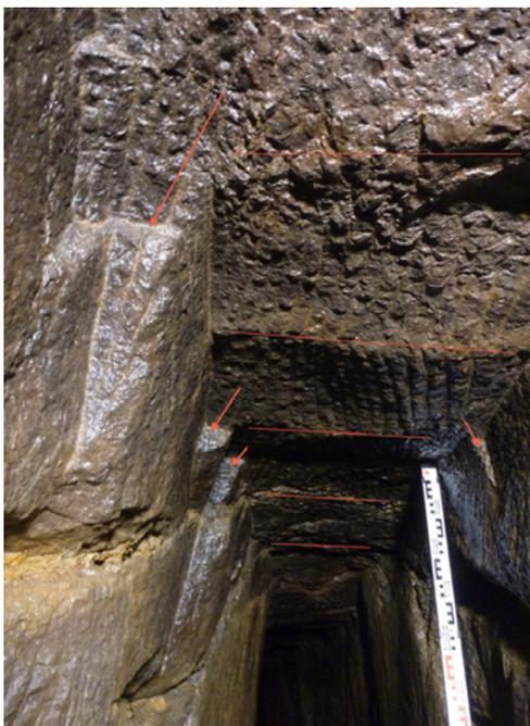
**Fig. 2 :** Wegscheid. Mine *Fürstenbau*. Plafond de la galerie. La succession des fronts de taille est marquée, tous les 25 à 35 cm.
